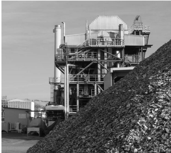
Fluidizált ágyas fagáz üzem (Güssing, Ausztria). Alapanyag: fahulladék
